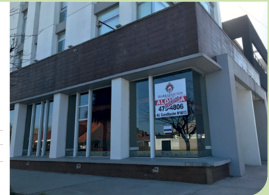
Locales gastronómicos cerrados y puestos en alquiler. Foto tomada en septiembre de 2020.
