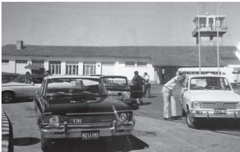
Foto 5. Vista del estacionamiento y exteriores, 1976
