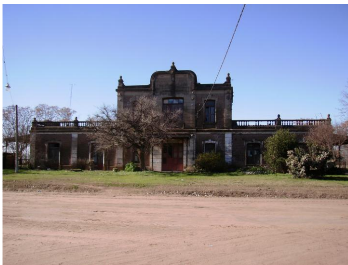
Antigua Estación de ferrocarril “La Trocha”
