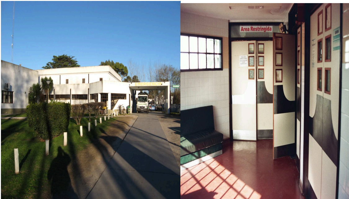
Foto: Izquierda: Acceso a la Guardia desde Bv. Belgrano y salida de Ambulancia. Derecha: Ingreso Sala de Guardia Emergencias
