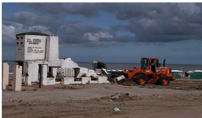
Imagen Nº 15: Autor anónimo. Demolición de balnearios con plazo de concesión vencidos. Publicada por la Secretaría de Turismo y Cultura de Villa Gesell, en Playas ETI (2006). Material propio.
