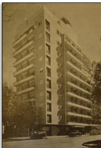
Edificio en Av. Colón (año 1957)
