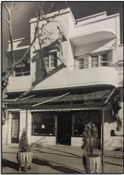
Local y vivienda en planta alta
