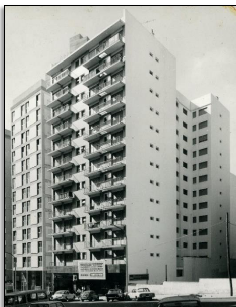
Edificio "Súper", año 1968
