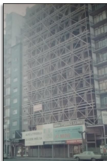
Edificio "Pedro Luro" (1968)
