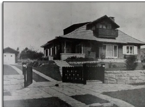
Residencia de verano estilo marplatense, Constructores Pulichino-Gentilini (1944)
