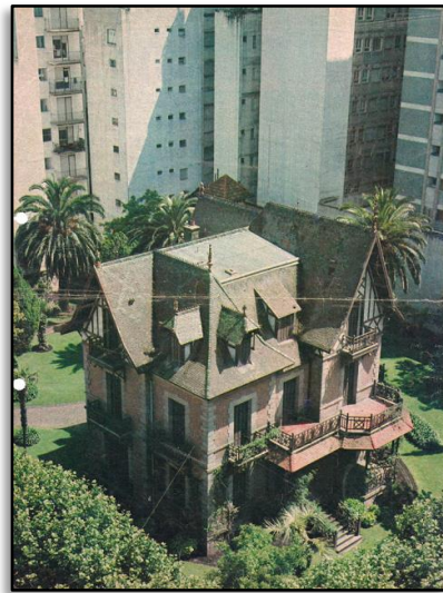
Chalet Villa María (1906). Demolido en 1990
