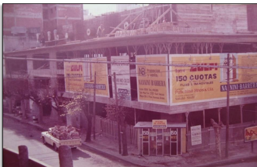
Foto 46. Torre Gulfi I en construcción, circa 1970
