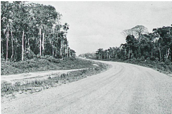
Figura 3. La carretera de Darién construida por la Morrison-Knudsen Company
