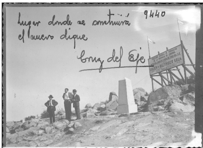
Figura 4. Técnicos y anuncio de construcción de un dique en Córdoba
