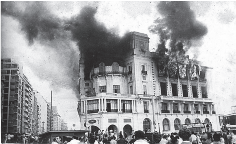
Foto 6. Incendio del Club Mar del Plata, 10 de febrero de 1961
