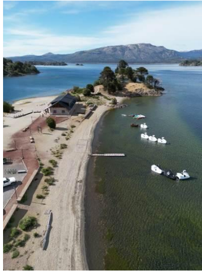
Figura 27. Sector del muelle con costa oeste, apta para bañarse. Fotografía aérea con dron
